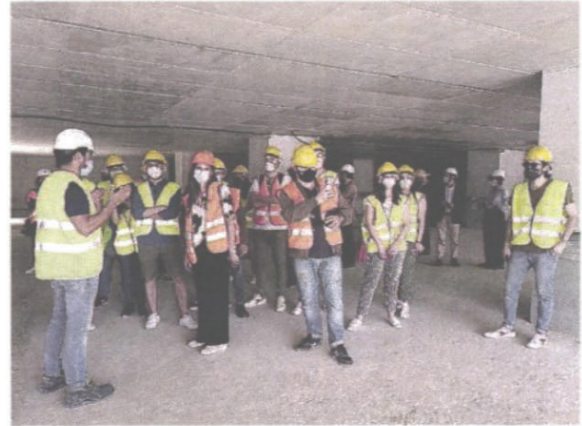
Una fase della visita nel cantiere
